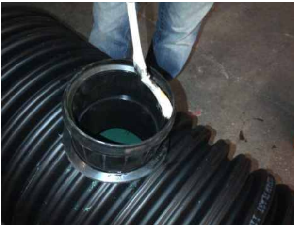
Смазване на уплътнението Ep1401 за свързване към PVC тръби
