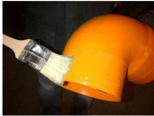
Смазване на фитинга преди свързване
