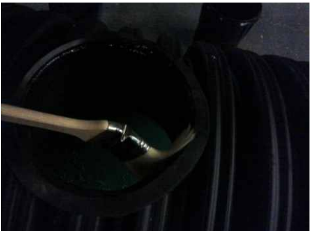
Смазване вътрешната част на уплътнителя
