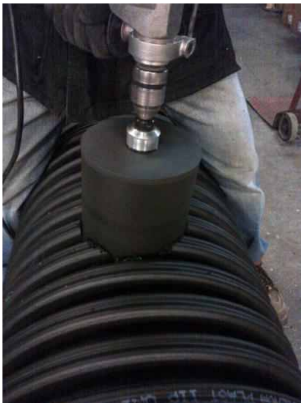
Пробиване на основната тръба
