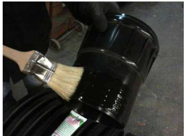
Смазване външната част на специалния фитинг
