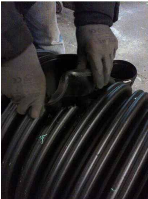
Позициониране на уплътнителя в отвора
