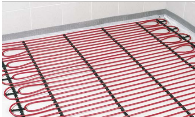
фиг. 3-114 Подова фиксираща шина при мокро строителство
