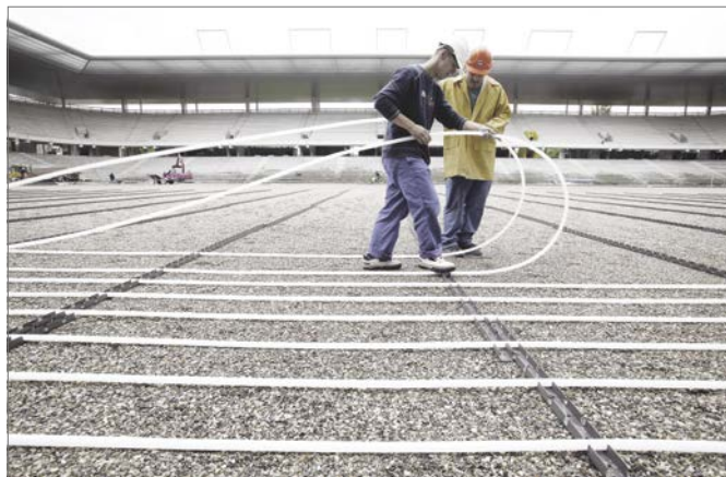
фиг. 12-3 Полагане на отоплителните тръби
