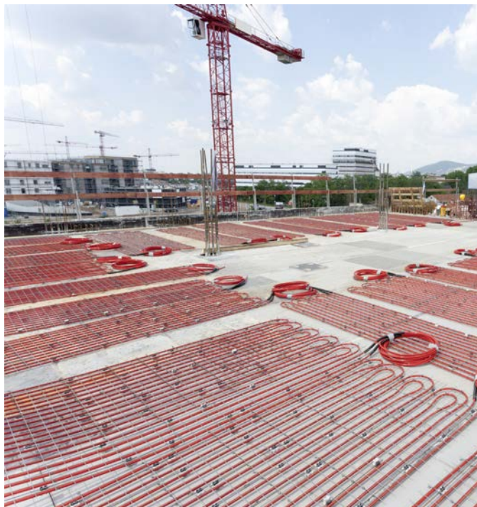
фиг. 7-62 Темперирание на бетоновото ядро/близко до повърхността темперирание на бетоновото ядро
