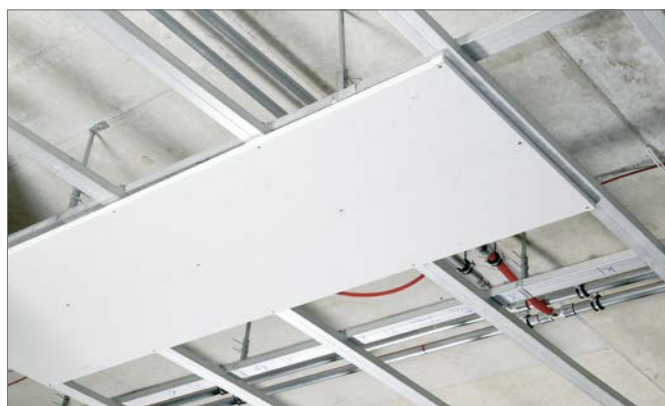
фиг. 4-37 Монтиран стенен елемент към таван
