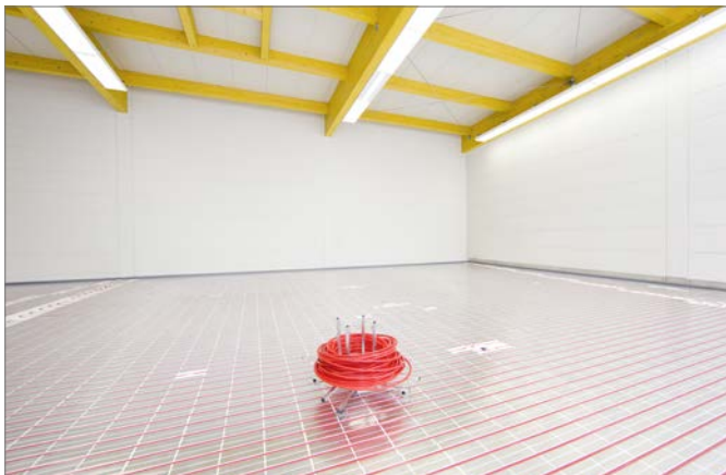
фиг. 10-1 Суха система за лъчисто отопление на вибриращ под
