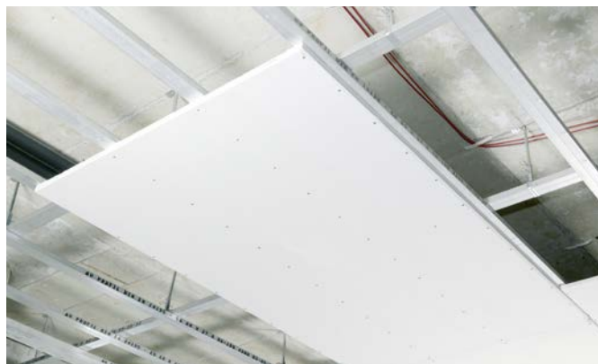
фиг. 4-5 Монтиран таванен елемент
