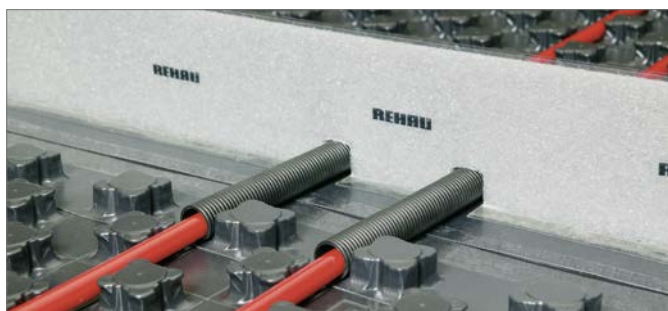
фиг. 5-4 Профил за разширителни фуги върху релефна плоча Varionova
