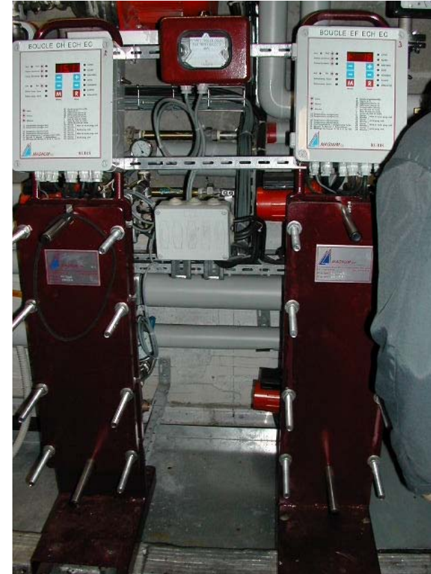
Equipement traitement d'eau Zone Hématologie Secteur protégé
