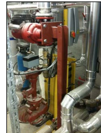
Production ECS semi-instantané Echangeur à plaques avec 2 ballons
