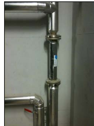
Réacteur 45-NT installé sur EFG Capacité de traitement : 25 m3/h
